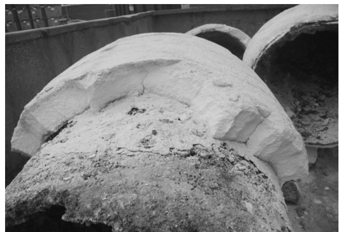
Bild 2. Übersicht über die gesamte Verfestigung der Ofenauskleidung
